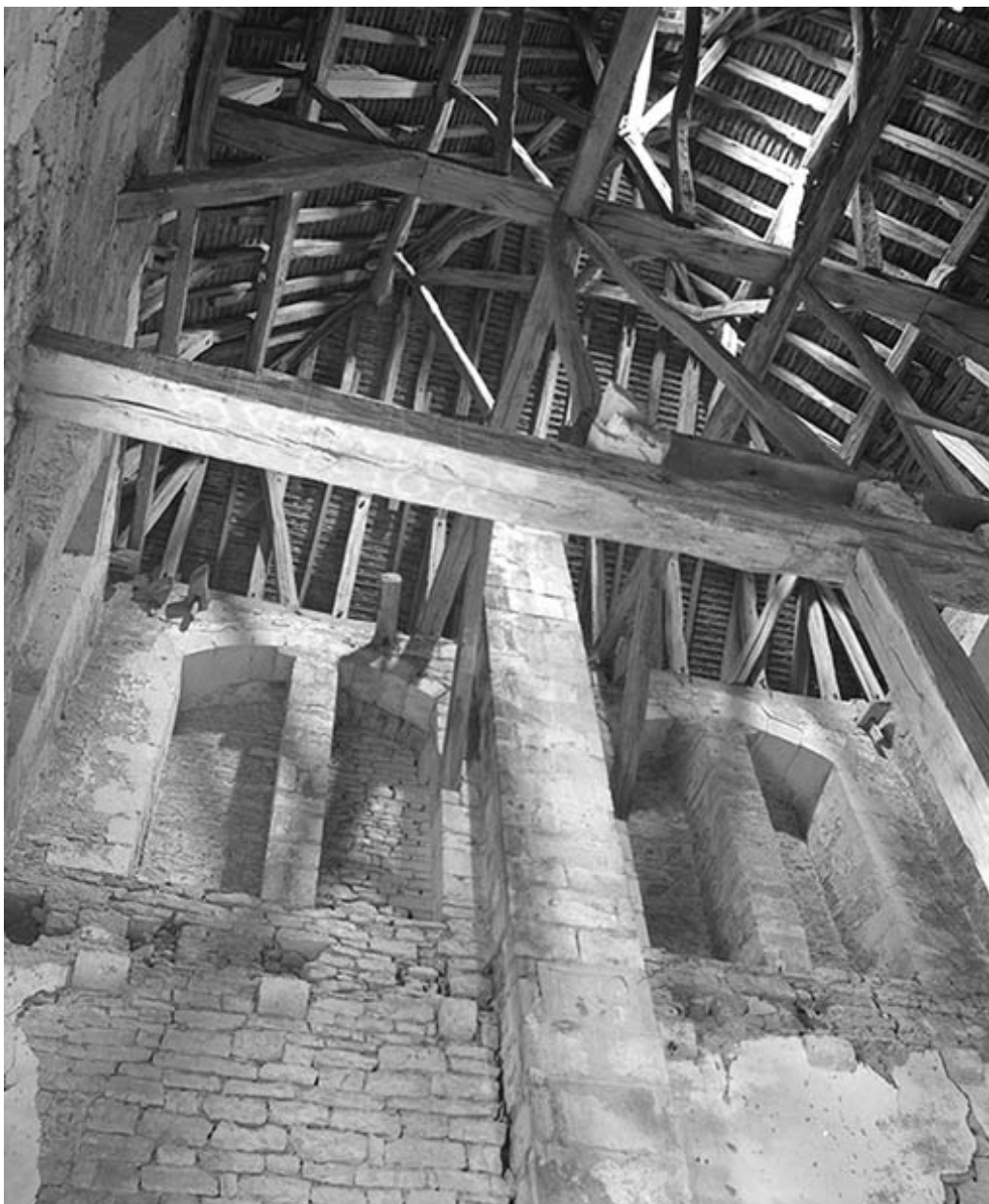
Baies murées de l'étage supérieur et charpente de la tour.
