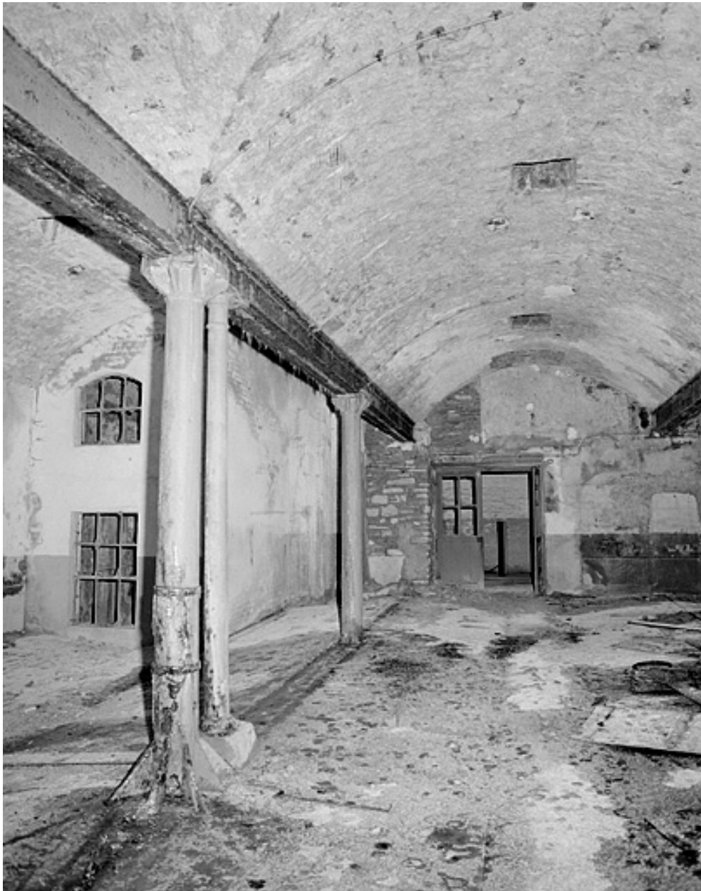
Premier étage, grande salle, côté ouest.
