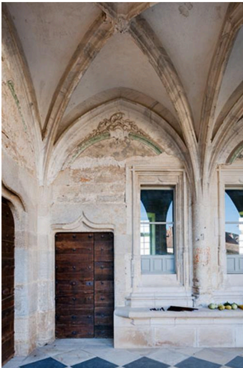
Baies situées au fond de la galerie
