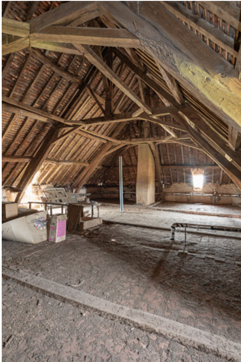
Vue de la charpente de la demeure
