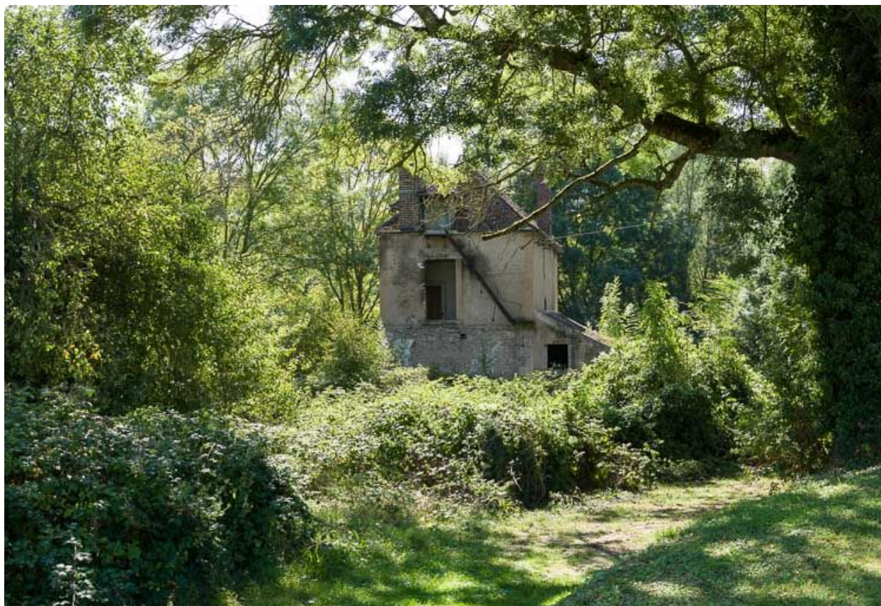
L'ancienne maison éclusière.
