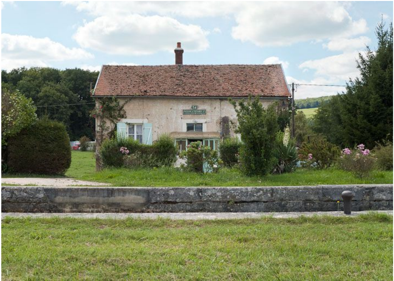
Vue de face de la maison éclusière.
