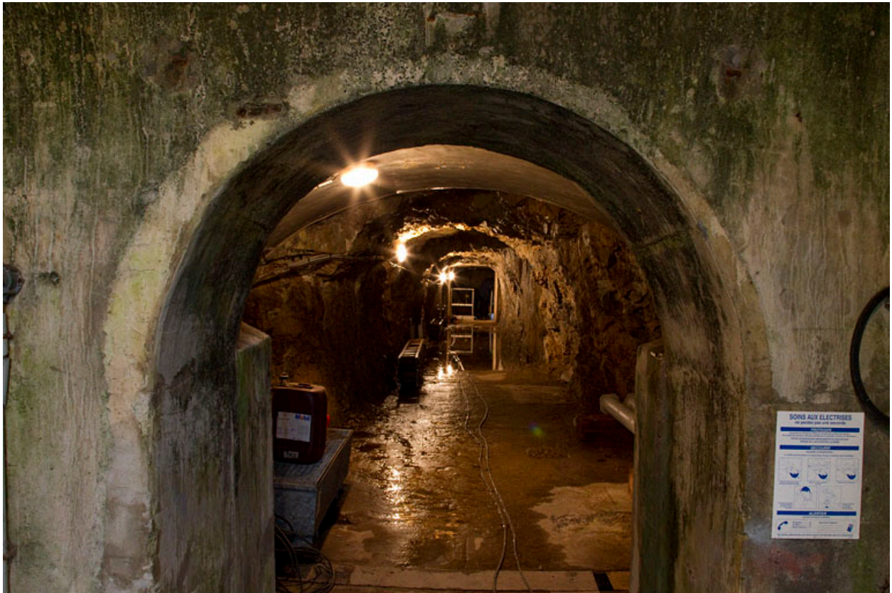
Tunnel d'amenée d'eau : galerie.
