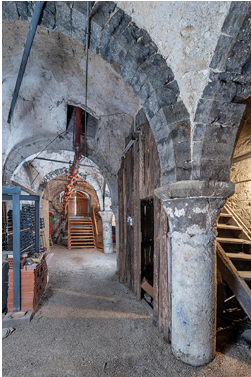
Vue d'ensemble de la cave, depuis l'est.
