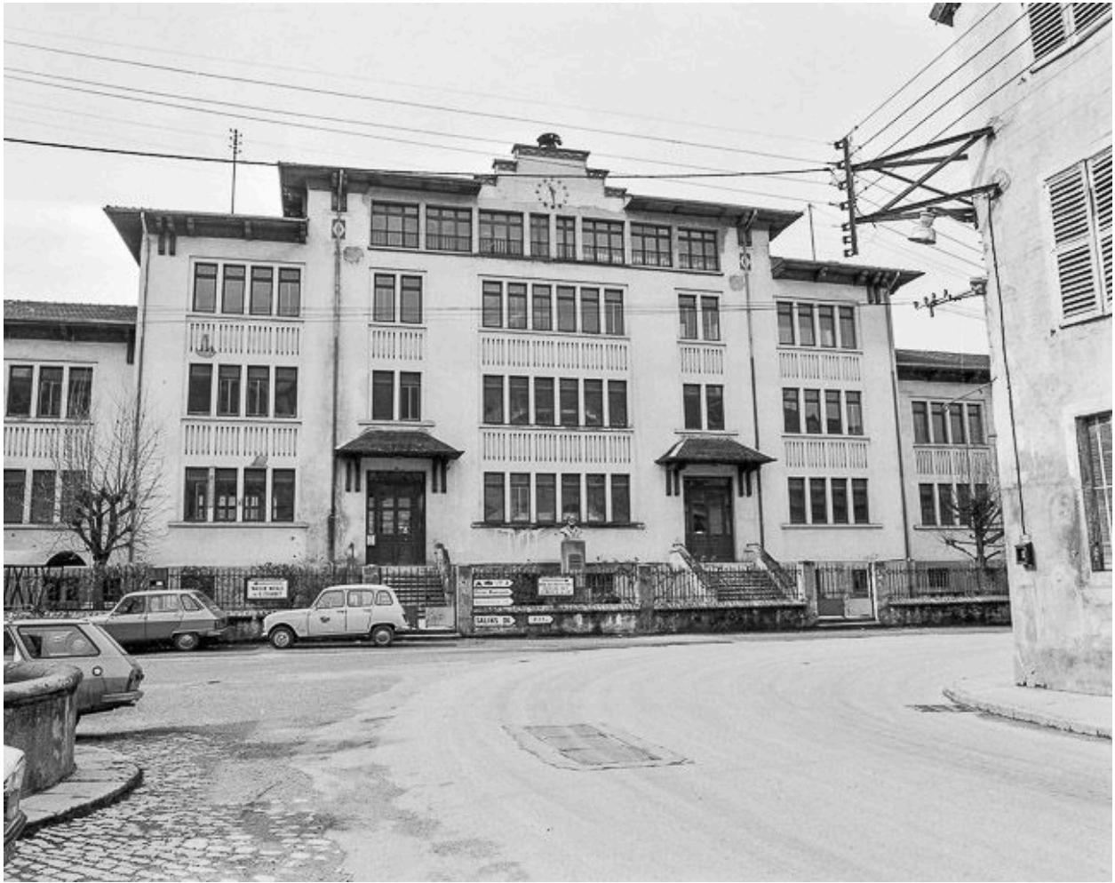
Vue d'ensemble (bâtiment détruit).
