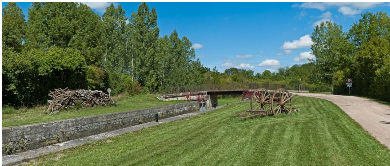
Vue d'ensemble du pont.
