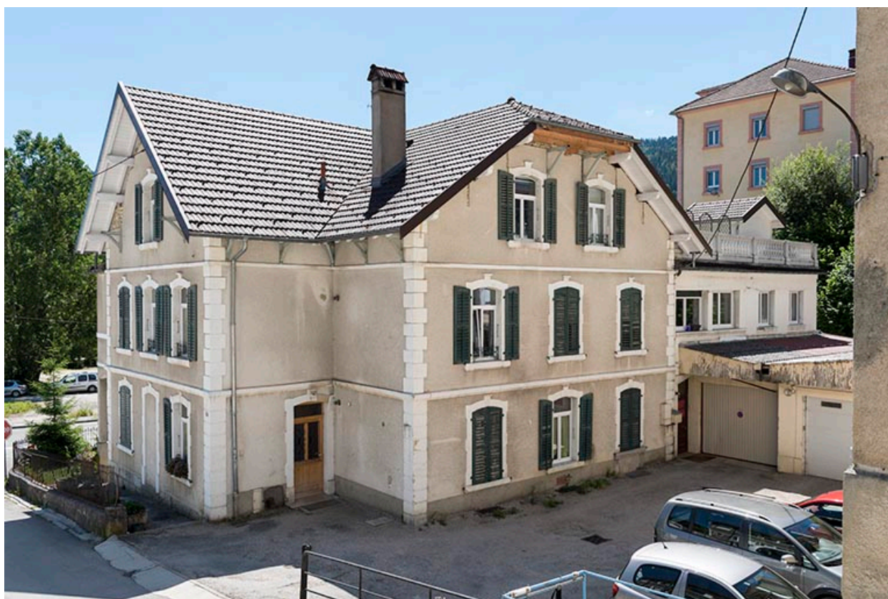
Maison : façades postérieure et latérale droite.
