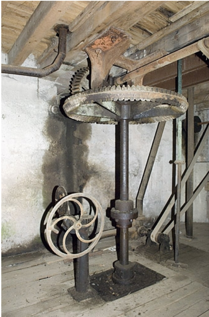
Système de transmission à l'aplomb de la turbine Goulut-Borne. Vue de côté.
