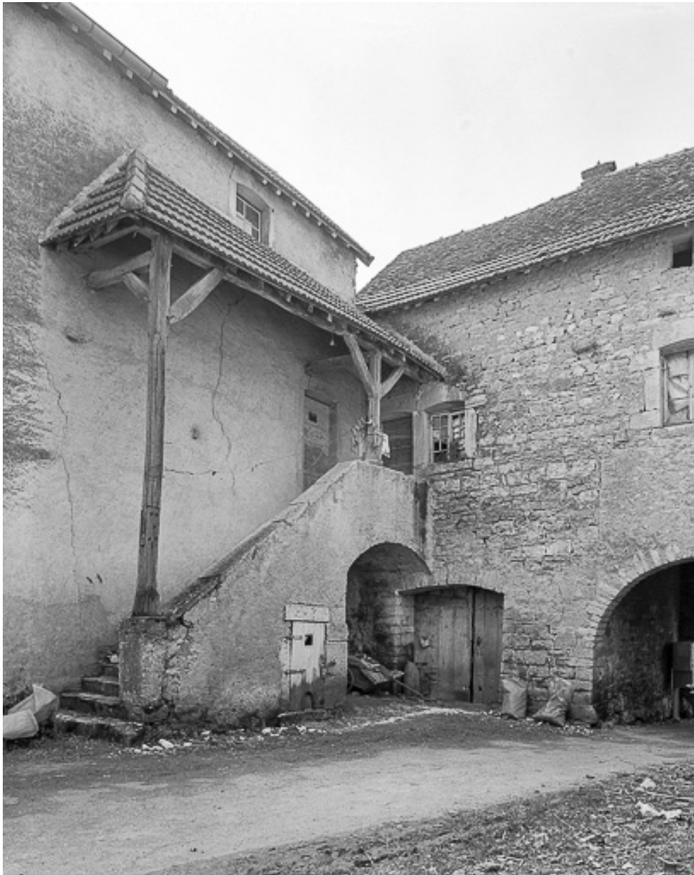
Vue de l'escalier extérieur.
