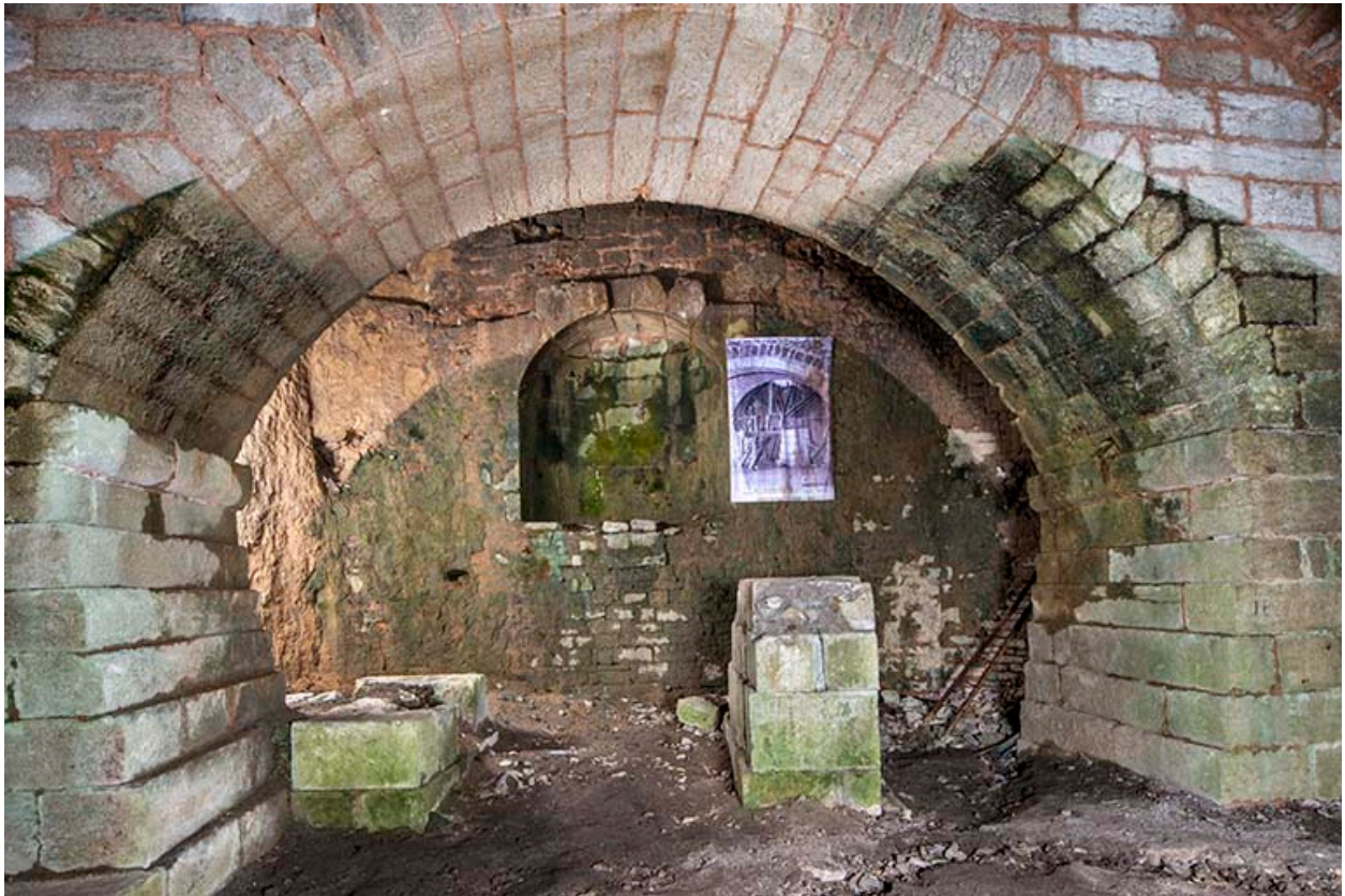
Extrémité nord du puits d'Aval. Massif maçonné de l'ancienne roue hydraulique.
