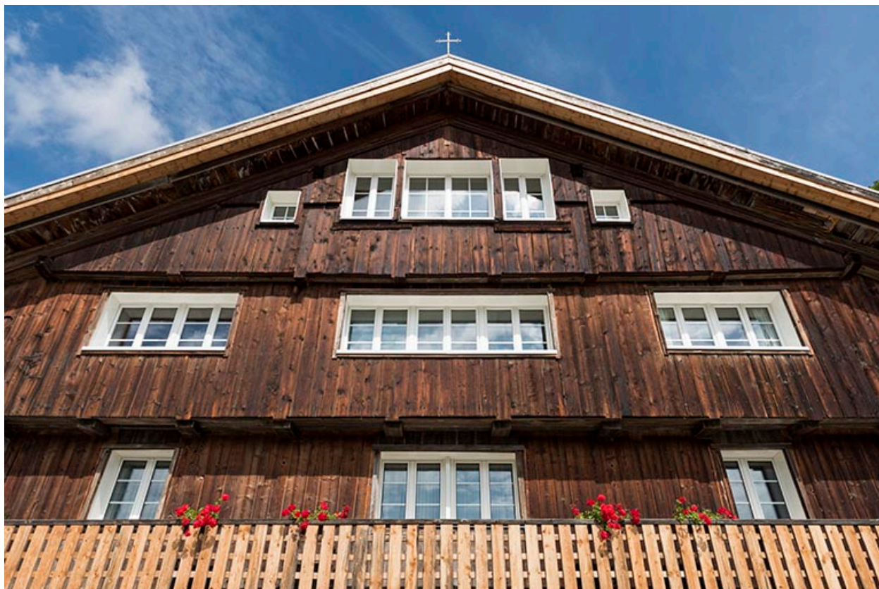
Façade antérieure, vue en contre-plongée.
