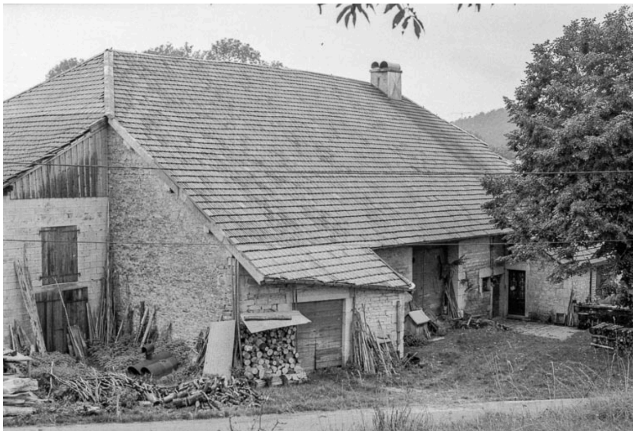
Ferme cadastrée 1939 F 28 : vue d'ensemble.
