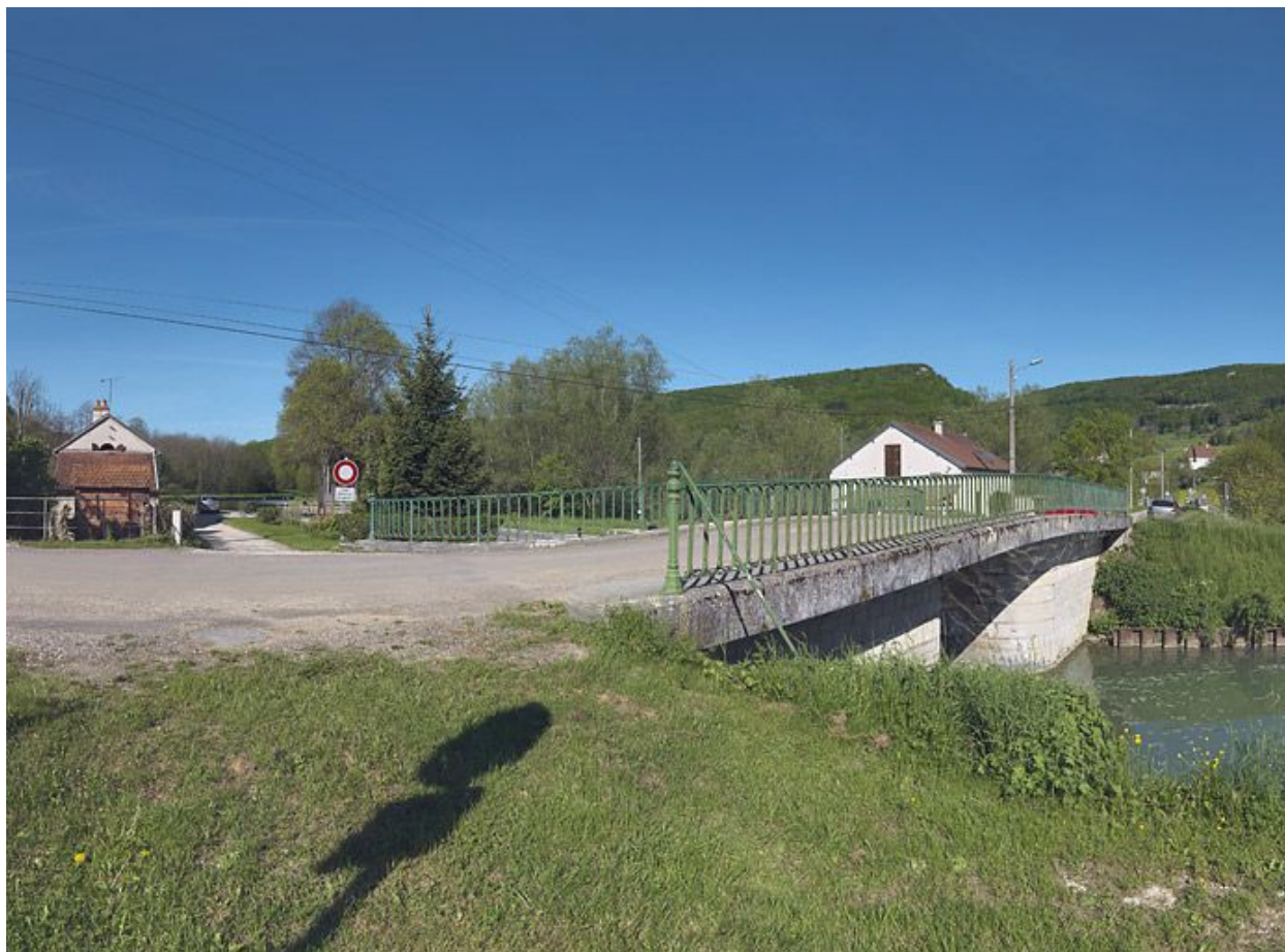
Pont sur écluse pris d'aval.
