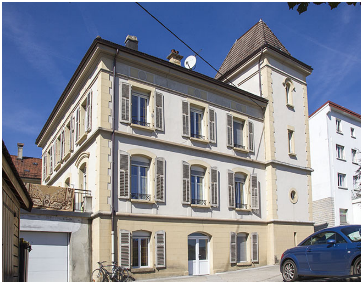
Façades postérieure et latérale droite.
