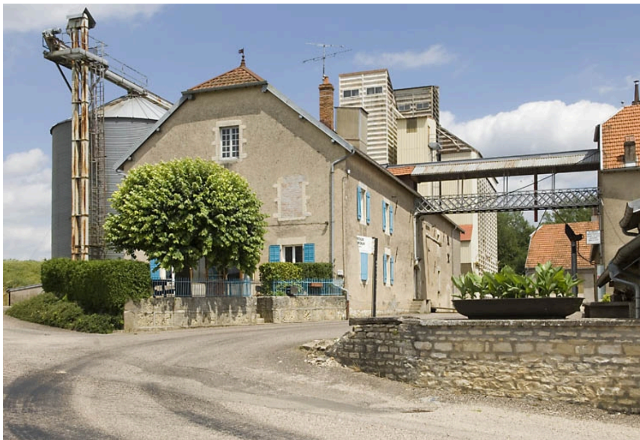
Silos et magasin industriel.
