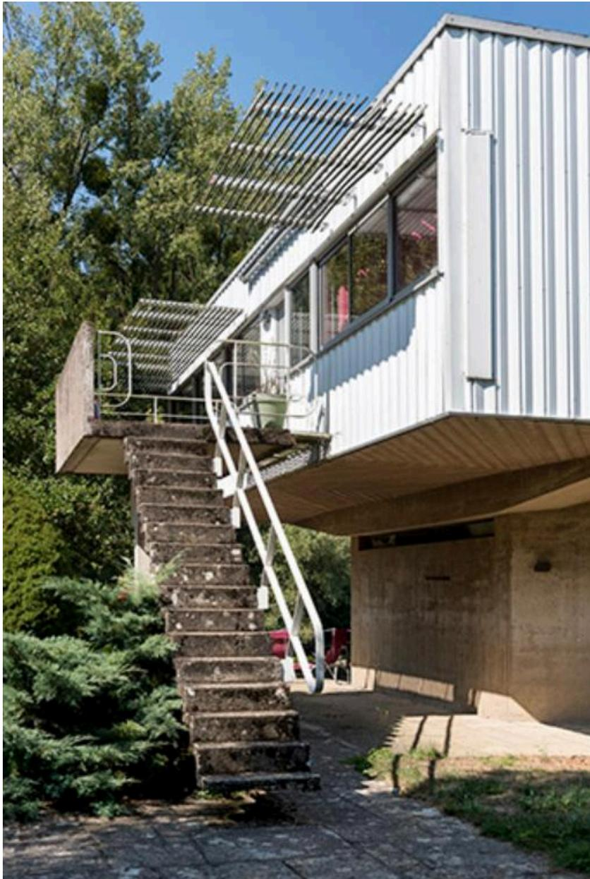
Villa, détails de l'escalier détaché du sol, du balcon et des pare-soleil métalliques
