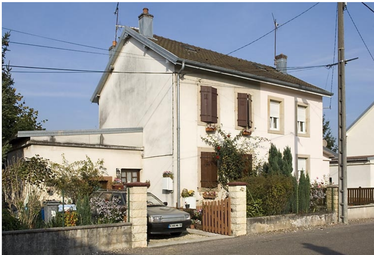
Logement ouvrier à 4 logements (rue Saint-Quentin).
