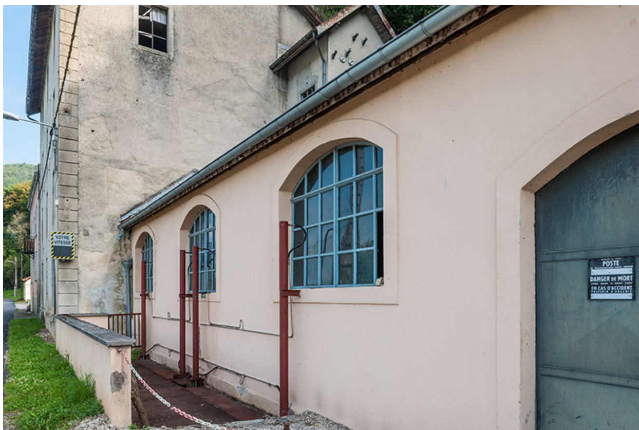
Vue rapprochée sur la centrale hydroélectrique.
