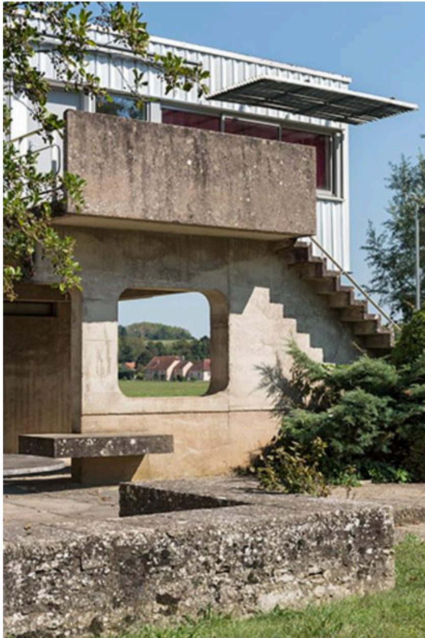
Façade ouest, et vue sur l'ancien moulin à travers l'ouverture dans le mur de l'escalier
