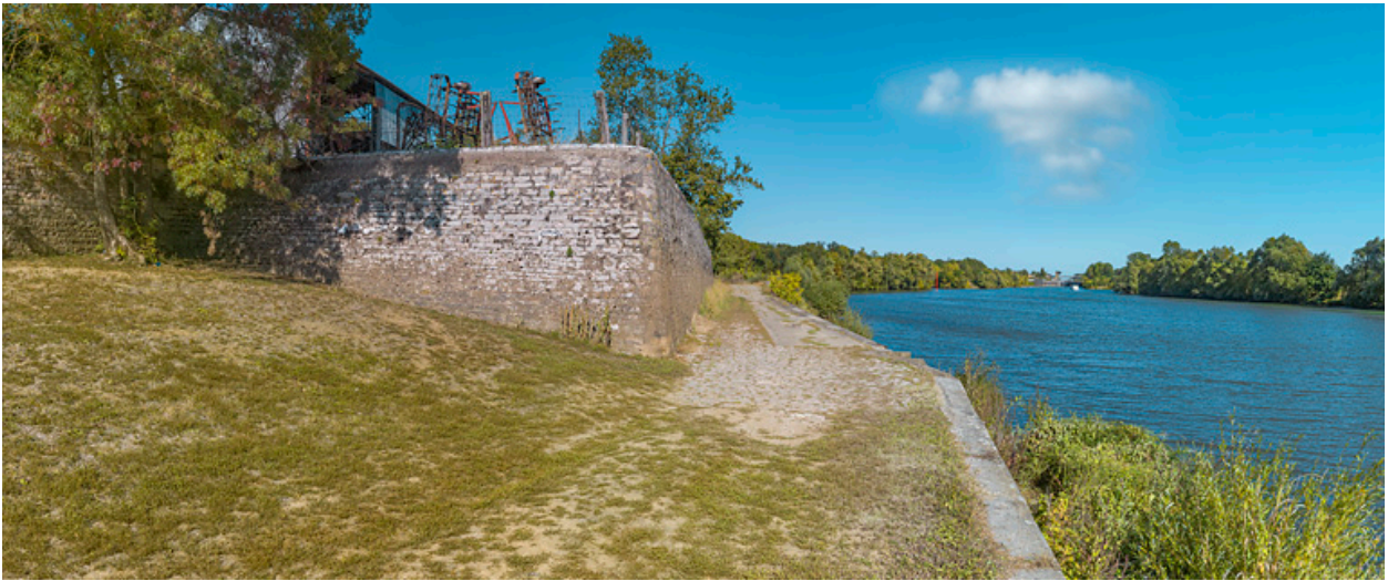
Les imposants murs en pierre, au niveau du port d'Écuellen.
