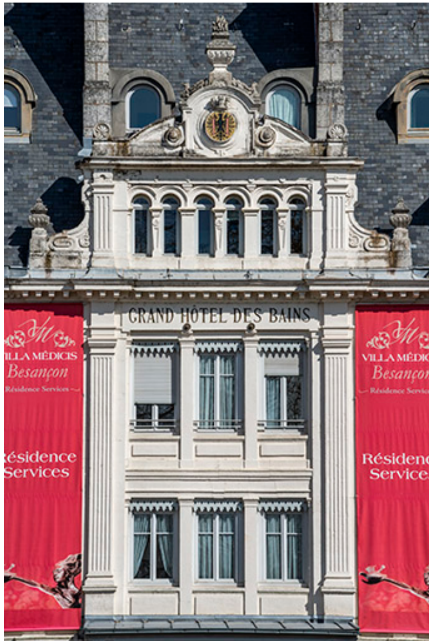
Façade sur l'avenue Édouard Droz, travées centrales, détail.
