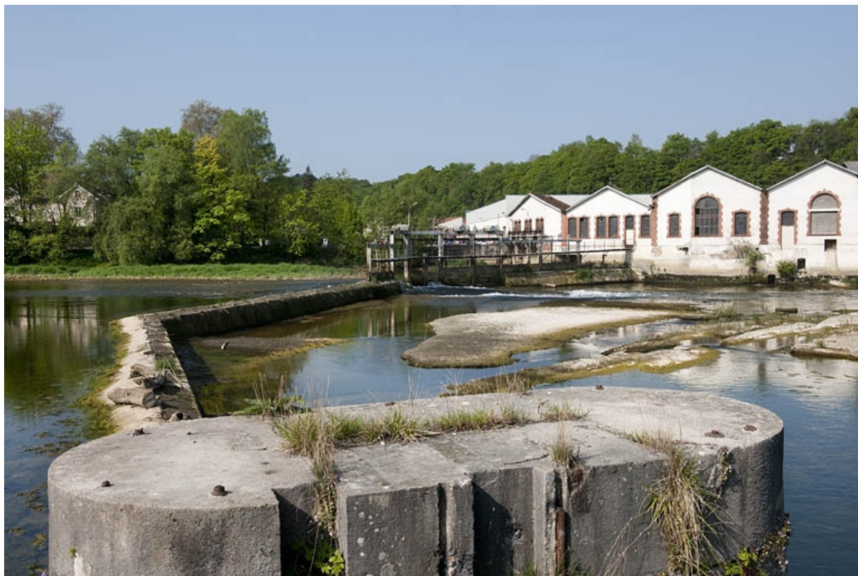
Le barrage depuis la rive droite.
