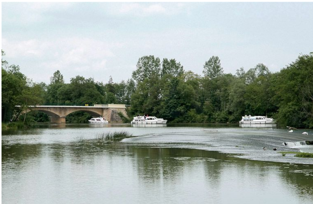
Le pont de Cuisery, vu d'aval.
