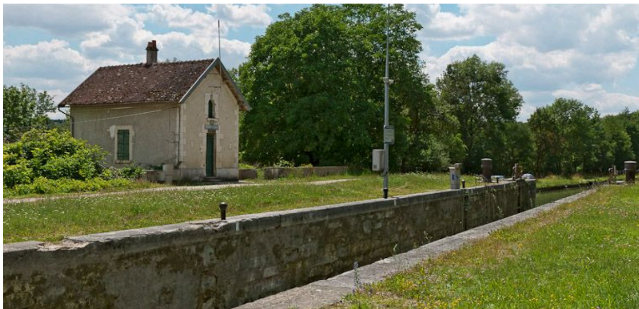
Vue d'ensemble du site d'écluse.
