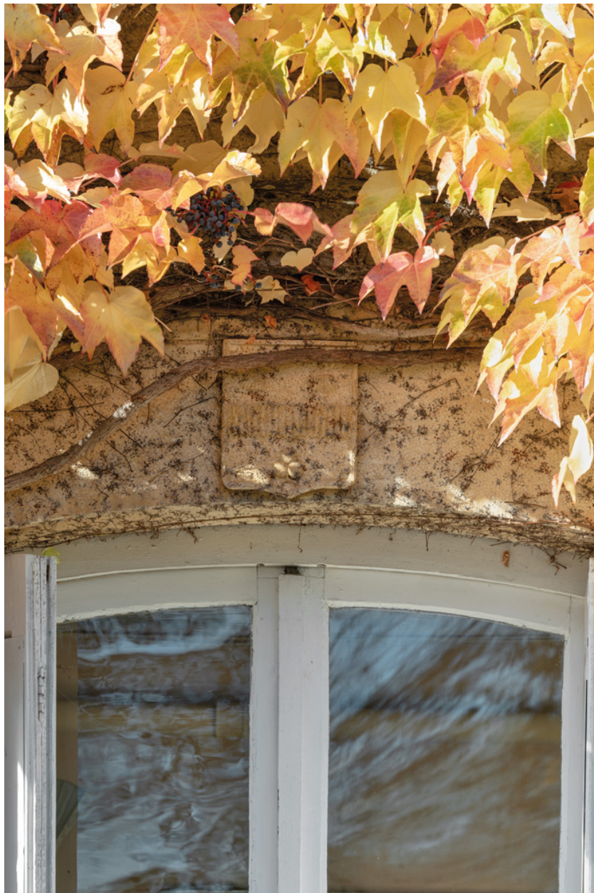
Logis. Détail d'un blason sur un linteau de la façade est.
