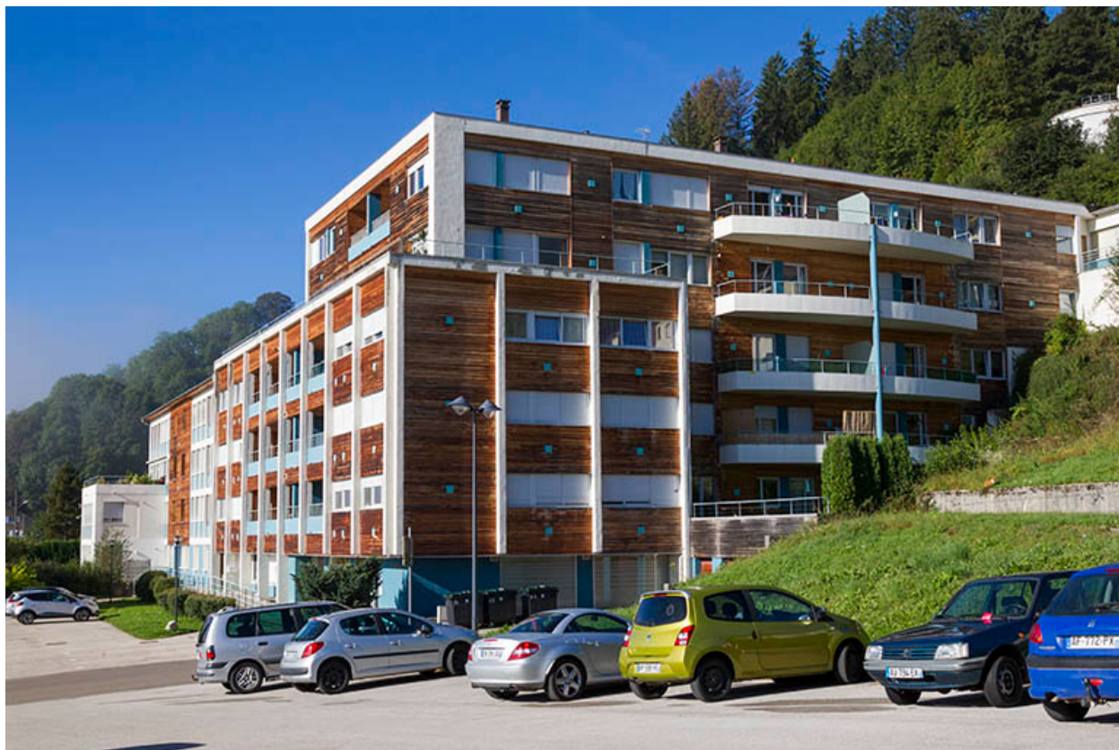
Façades antérieure et latérale droite.
