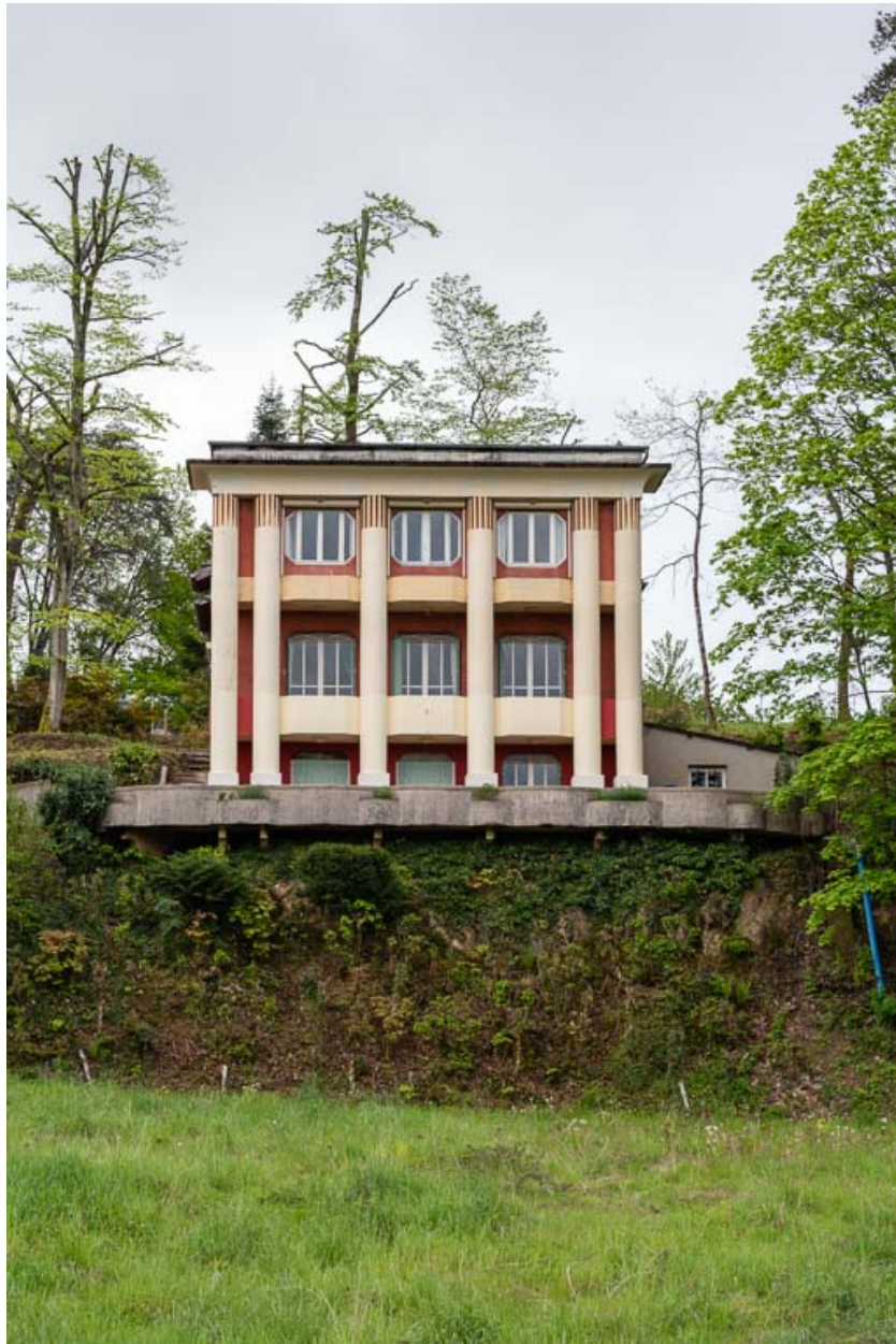
Façade nord, vue de face.
