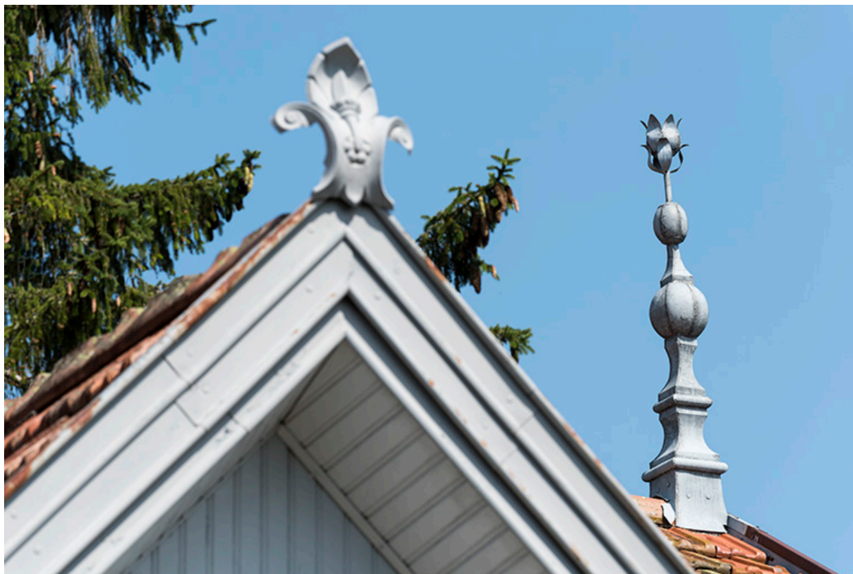
Ancienne ferme, façade antérieure : épis de faitage.
