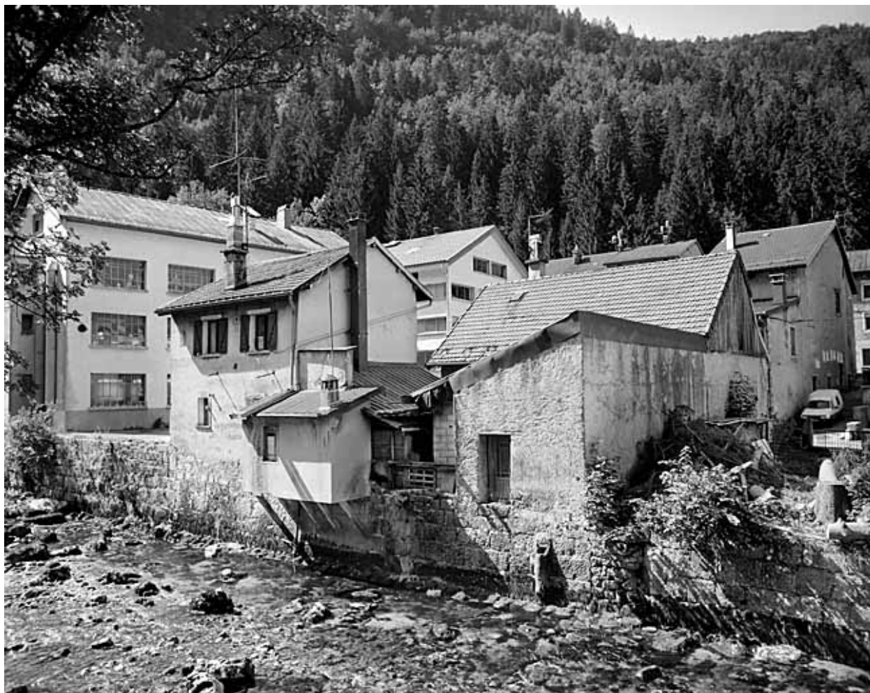
Vue d'ensemble, depuis le nord-est : élévations postérieures.
