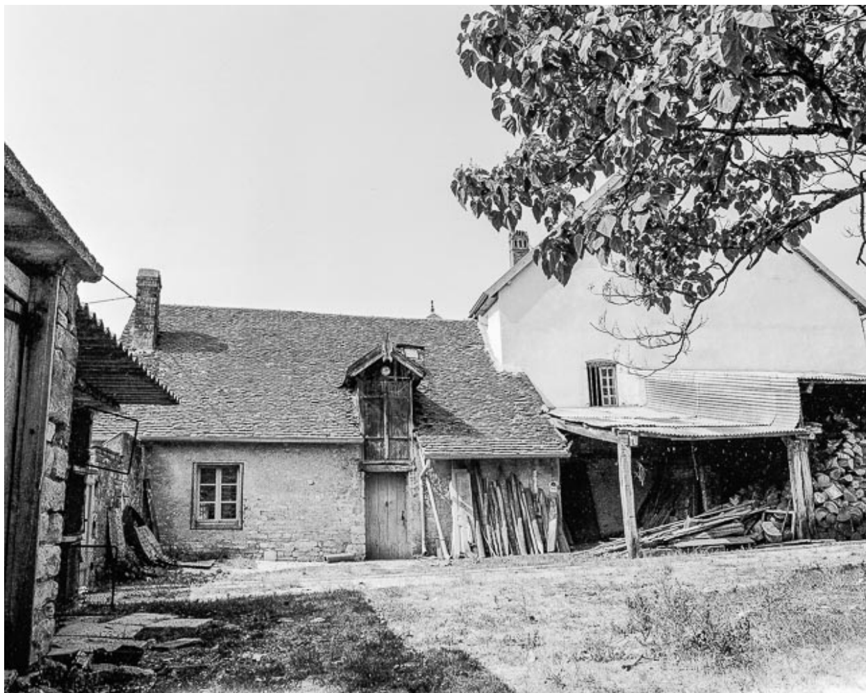
Maison cadastrée 1973 AB 11 située rue d'Aval à Chenevrey : détail de la façade latérale droite.
