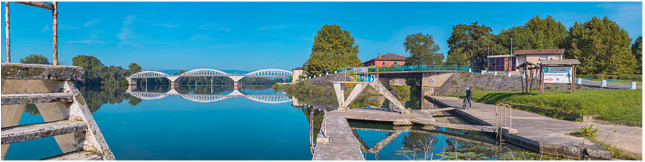
Le pont de Thoissey et le pont sur la Chalaronne, vus d'aval, depuis la rive gauche.
