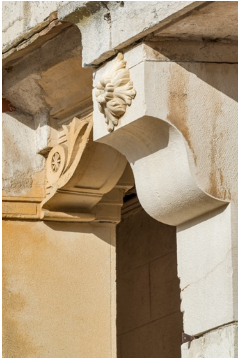
Galerie : supports côté cour (corbeaux).
