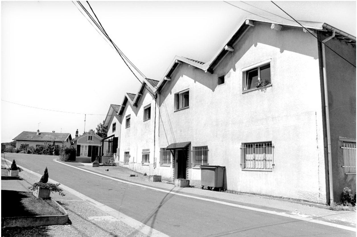
Murs-pignons des ateliers de fabrication.
