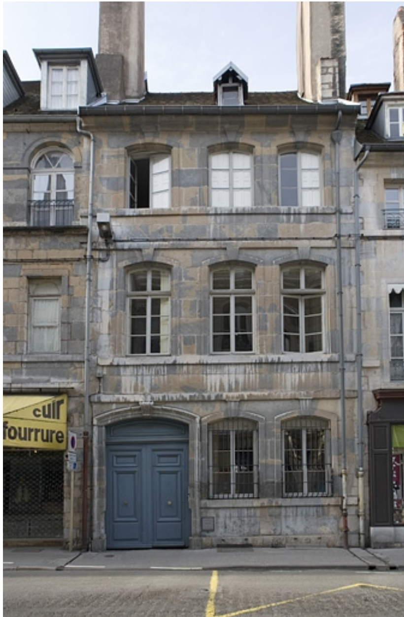
Façade sur rue, de face.
