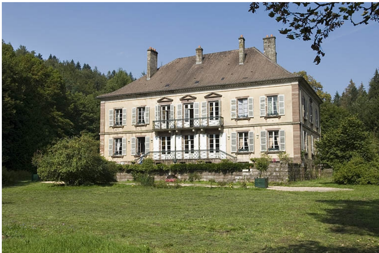
Façade sud vue de trois quarts droite.
