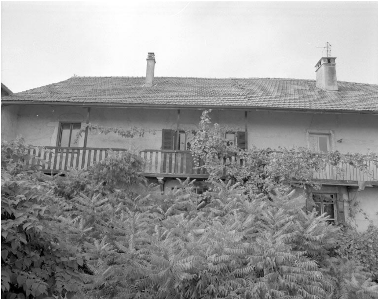
Façade antérieure, balcon.
