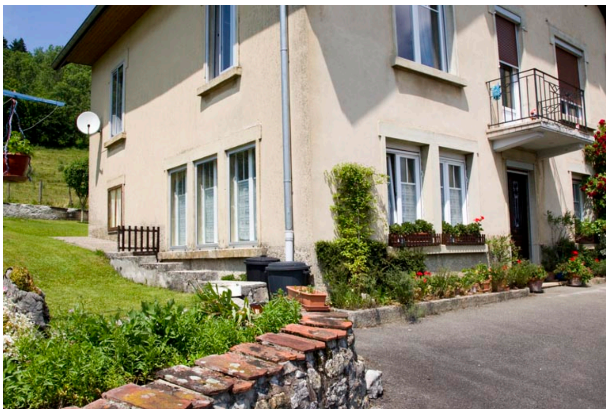
Fenêtres de l'atelier.
