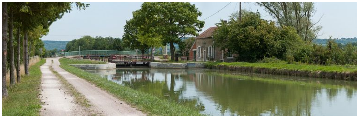
Vue d'ensemble du site d'écluse.
