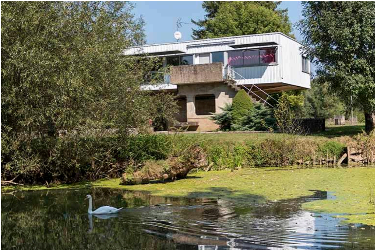
La villa, façade ouest, vue depuis la rive d'en face
