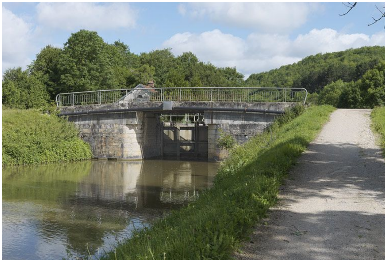
Vue d'ensemble du pont sur écluse.
