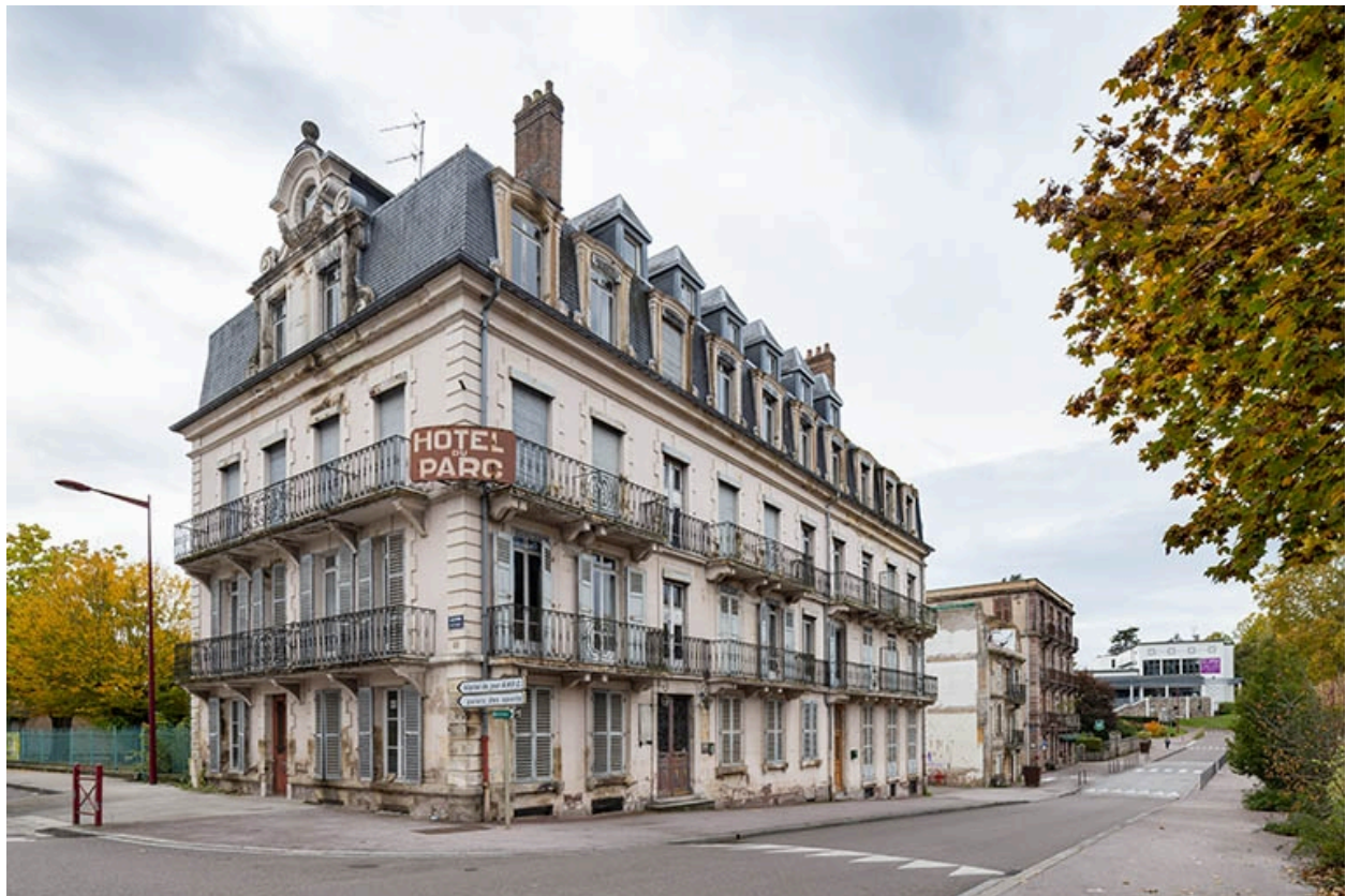
Façade nord et façade est, vue depuis l'angle du boulevard Richet (à gauche) et de la rue des Thermes (à droite).
