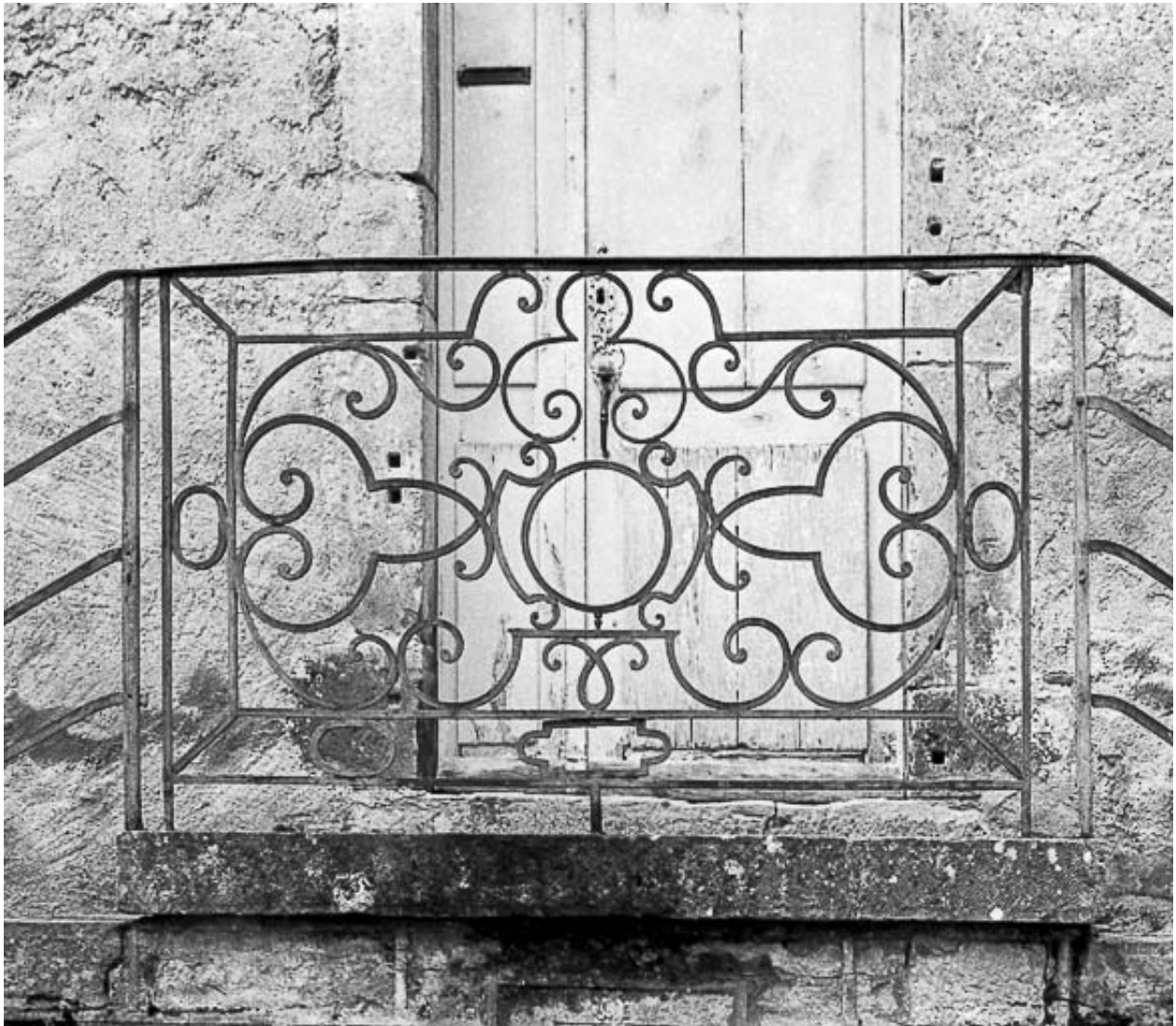
Maison située rue de la Roche, avec escalier à double volée: détail de la rampe en fer forgé.
