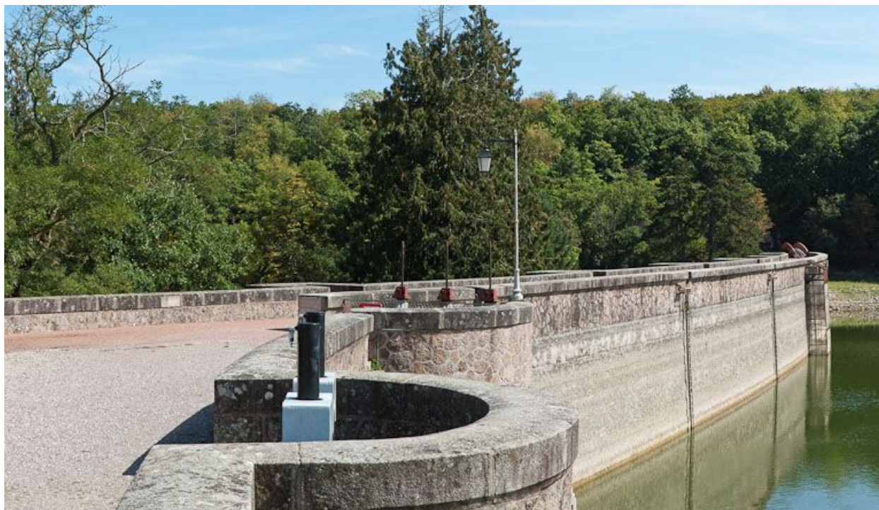
Vue de la digue du réservoir.
