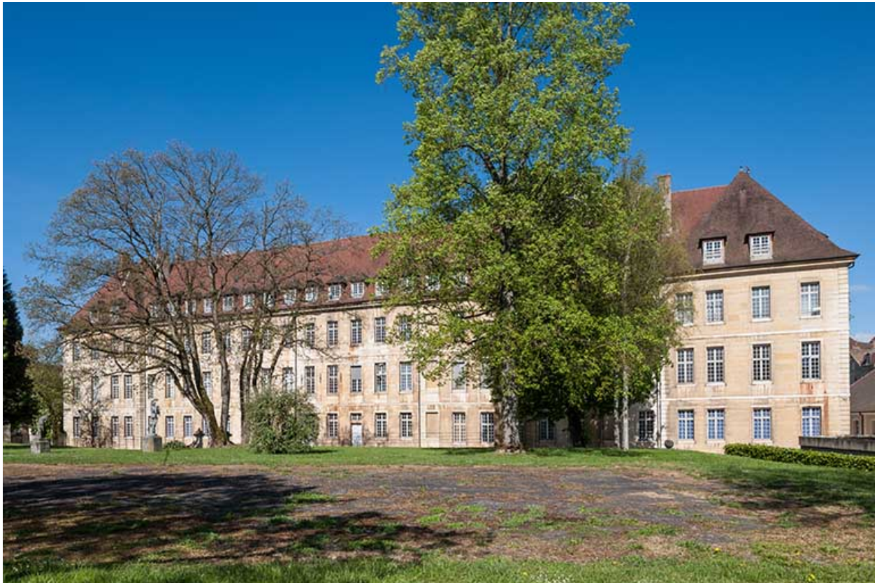
Ancien hôpital de la Charité, actuellement internat, vue postérieure sur le parc.
