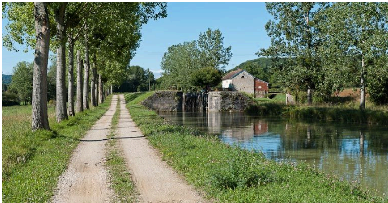
Vue du site d'écluse depuis l'aval.
