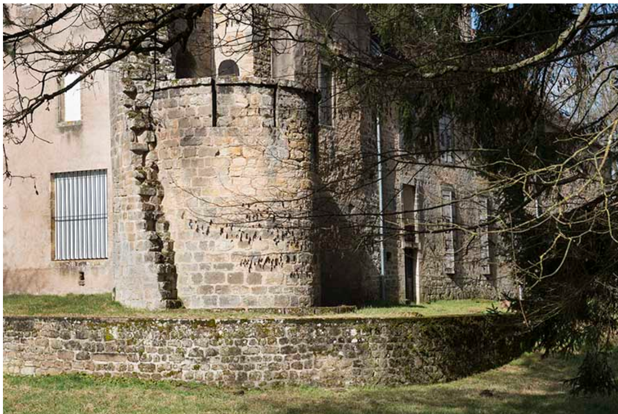
Détail sur la maçonnerie de la tour.
